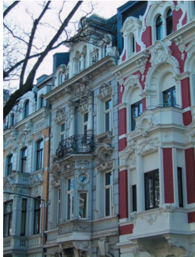
Ein prägendes Element wie ein großes Potenzial des Viertels stellt die klassische Gründerzeitbebauung dar.
